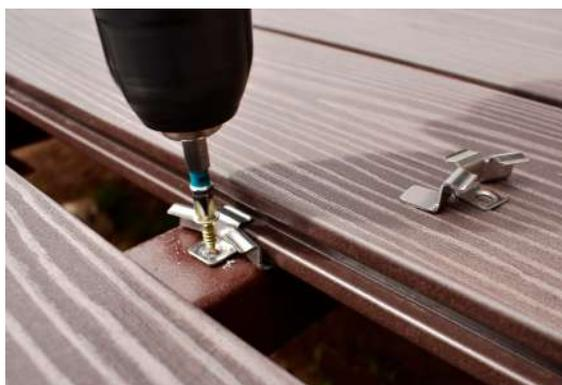
**2.3** При температурах ниже 5°C лучше отказаться от укладки покрытия, в противном случае необходимо очень аккуратно производить укладку террасной доски [RusDecking](#), так как, при низких температурах, ввиду линейного расширения, доска может изменить свои габариты по длине, ширине, и толщине в меньшую сторону.
